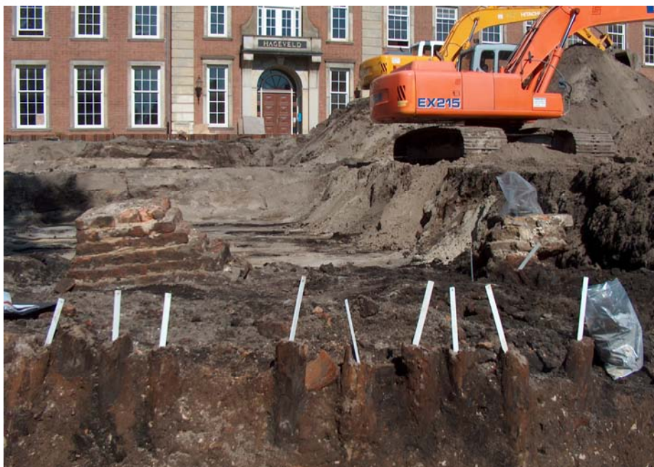
Afbeelding 3.1: de archeologische veldwerkzaamheden ter plaatse van de geplande parkeerkelder, gezien vanuit het westen.
