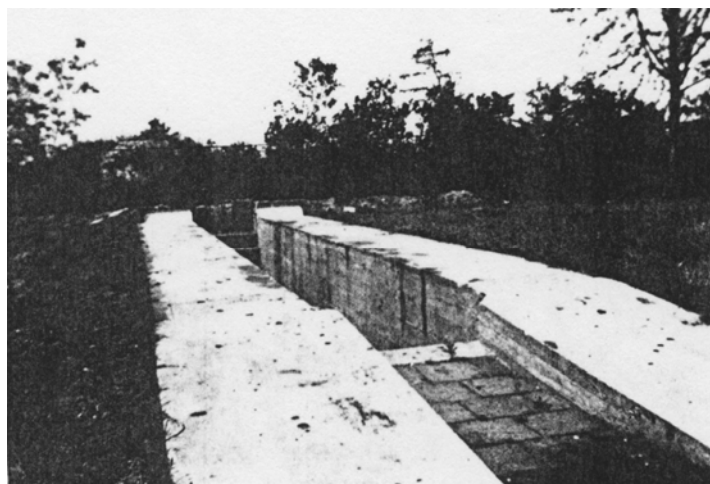
Afbeelding 2.30: zicht op een deel van een loopgraaf in het Hertekamp. Bron: Provinciaal Archief Noord-Holland.
