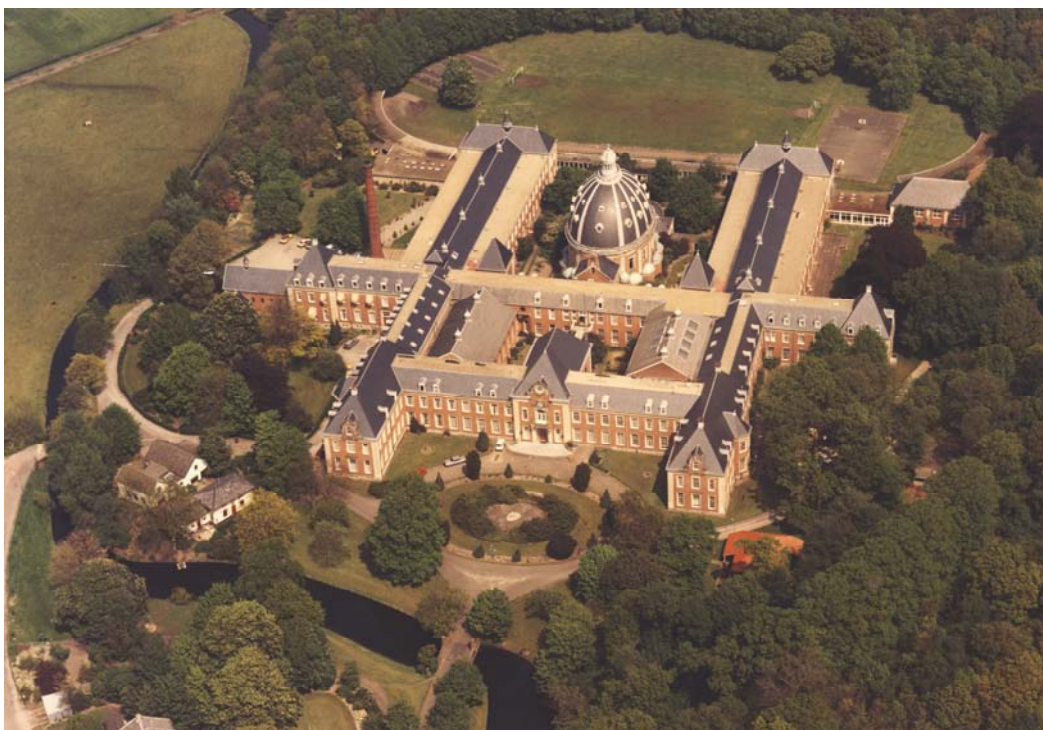
Afbeelding 1.1: zicht op het voormalig Bisschoppelijk Seminarie Hageveld (luchtfoto uit 1983). De gebouwen aan de voorzijde (voorhuis) worden tot appartementen en woningen omgebouwd, de achterzijde van het gebouw wordt in gebruik genomen door een school. Onder de vijver aan de voorzijde werd een parkeerkelder gerealiseerd.
