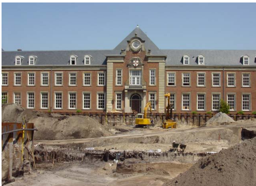
Afbeelding 1.2: zicht op de onderzoekslocatie en het voorhuis van het voormalig Bisschoppelijk Seminarie Hageveld, gezien vanuit het westen.
