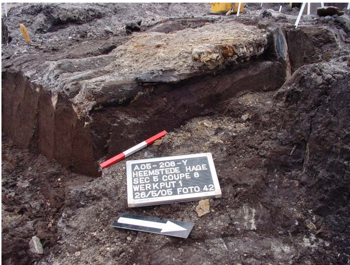
Afbeelding 3.20: zicht op een coupe op spoor 139, gezien vanuit het noordoosten. De bakstenen (of houten) bovenbouw van deze poer werd later uitgebroken. Deze fundering bestond uit een constructie van vooral horizontale en enkele verticale houten balken waarop een mortel- en puinpakket aangebracht werd dat als basis diende voor de bovenbouw.
