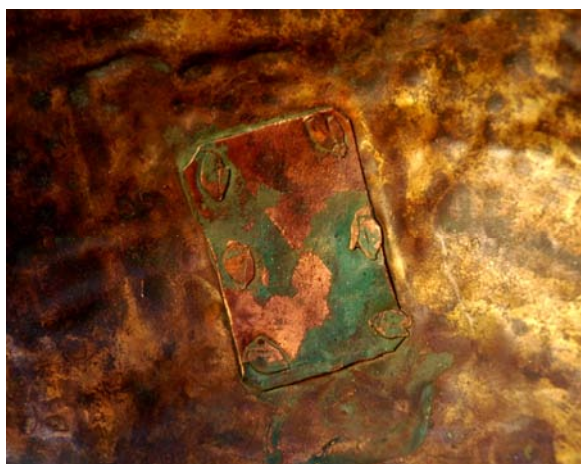
Afbeelding 5.14: binnenkant ketel met lapstuk en holle klinknagel. Afbeelding 5.15: dezelfde reparatie vanaf de buitenkant.
