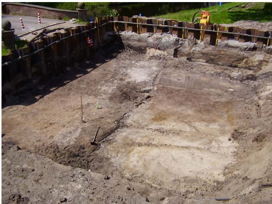
Afbeelding 3.31: zicht vanop het zuidprofiel op sectie A10, gezien vanuit het zuidoosten. In deze sectie is duidelijk de overgang van de strandwalafzettingen (onderin rechts) naar de venige zone (achterin) zichtbaar. In het midden van de foto is een restant van de 17 e -18 e eeuwse slootvulling (spoor 443) te zien.
