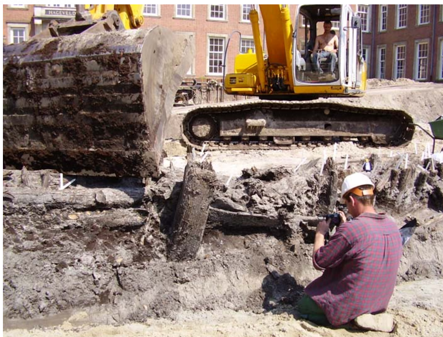
Afbeelding 3.23: zicht op de beschoeiing van de kloostersloot ter hoogte van structuur 5, gezien vanaf het westen. Door intensief gebruik van de oever hielden de beschoeiingspalen lichtjes over in de richting van de sloot.
