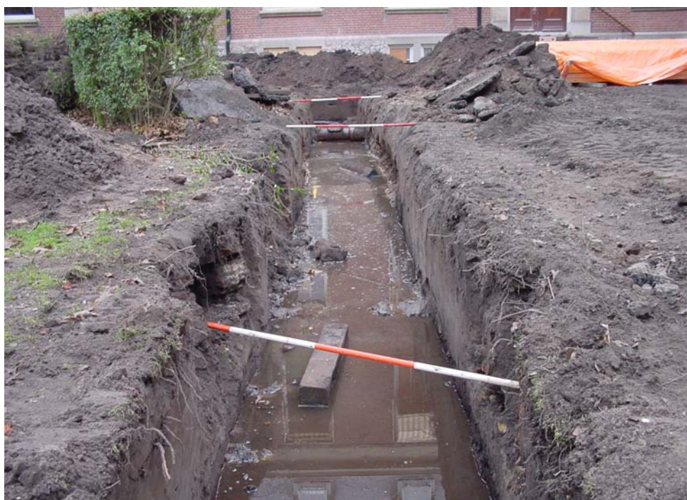
Afbeelding 2.42: zicht op de aangelegde sleuf, gezien vanuit het westen. De oriëntatie van de aanwezige grondsporen en resten werden met jalons weergegeven. Vooraan was een 18 e eeuwse riolering aanwezig, achteraan wordt het verloop van de aanwezige sloot zichtbaar.
